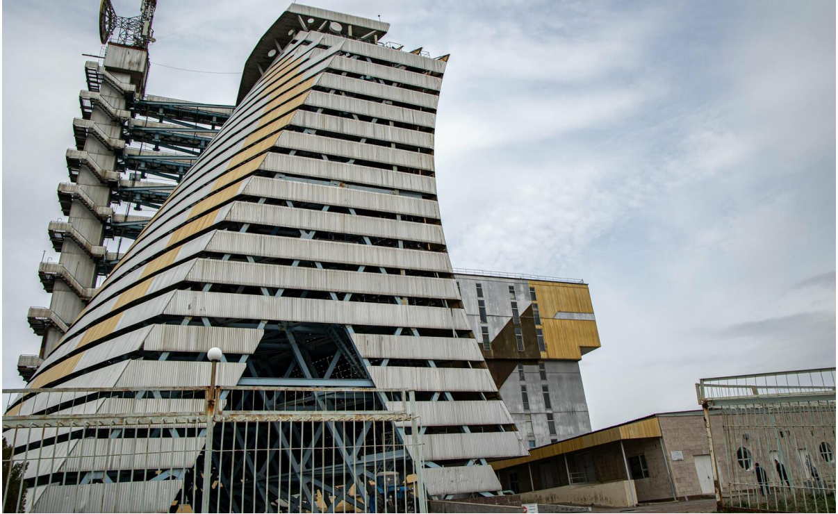
48-rasm. Ushbu inshoot dunyodagi eng katta pech hisoblanadi. Uning faoliyati uchta tarkibiy majmua: 62 geliostat, konsentrator va pechning o‘zidan tashkil topadi.
